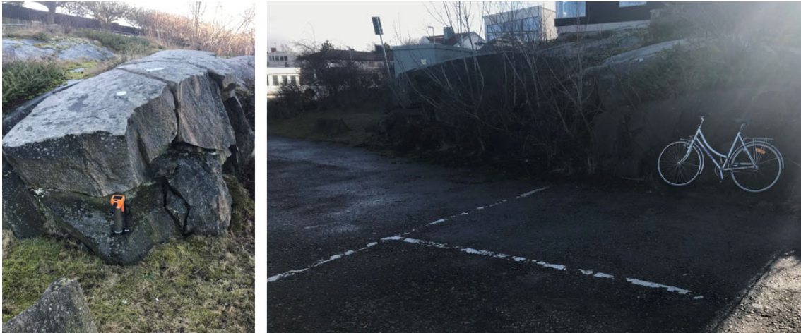
Figur 15. Slänt E; delvis sprängd låg bergskärning. Till vänster syns ett par lösa block på skärningens östra ände. Också synlig i bild till vänster är den orangea gammaspectrometern.
