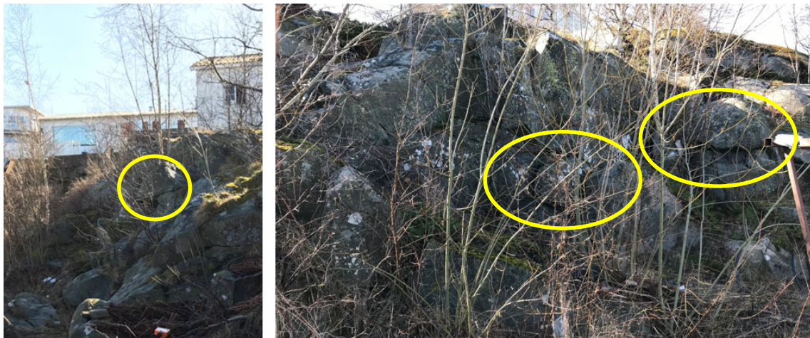
Figur 12. Slänt A, med inringade problemblock till vänster och höger. Närbild på inringat problemområde från Figur 11 synligt till vänster.
