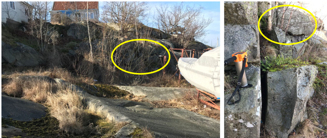
Figur 11. Slänt A innehåller en del lösa block men de flacka undulerande sprickplanen som dessa vilar på leder till bedömningen att ras är osannolikt. Sly gjorde slänten svår fotograferad. Huvudsakligt problemområde inringat i gult i bilden till vänster.
